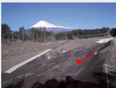
砂沢沈砂地工
