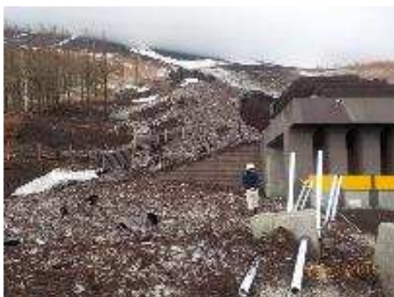
スラッシュ雪崩による被災例
