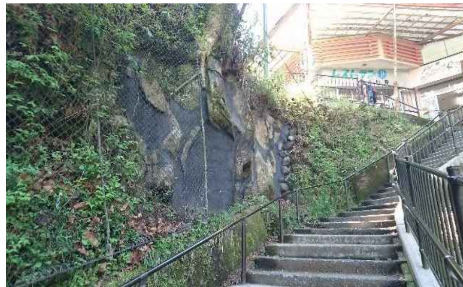
階段沿い岩盤補強工事
