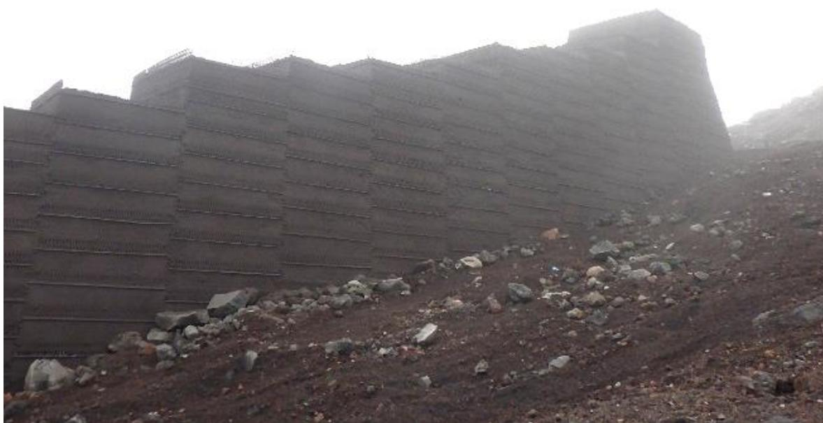
写真 導流堤施工例(着色後)
