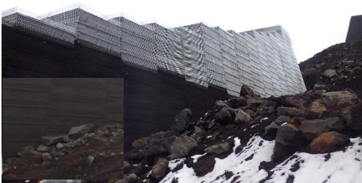
写真 導流堤施工例(着色前)
