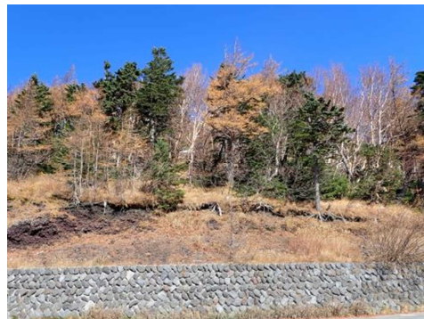
▼ 視点2：下部道路より正面を見る
