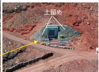
【既存施設】 緊急避難小屋
