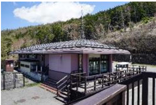
写真19 定点観測地点（大沢駐車場）
