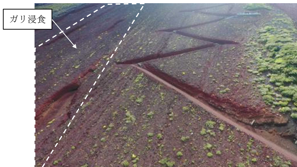
写真5 ガリ浸食が進行している様子
