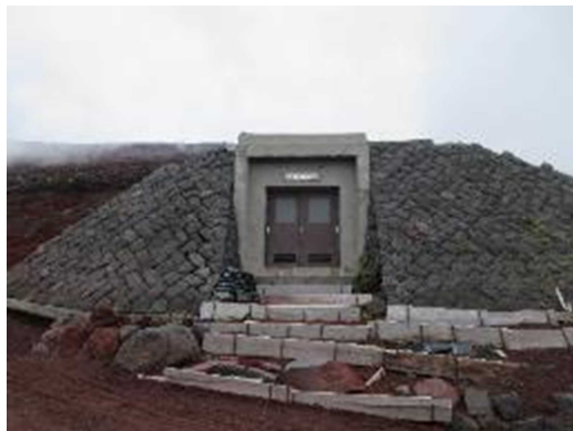
写真 15 本事業箇所と同規模の施工例
