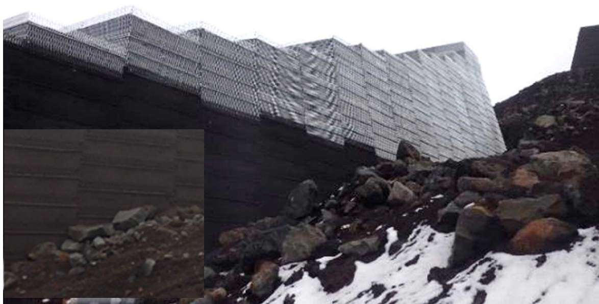
写真13 導流堤施工例(着色前)
