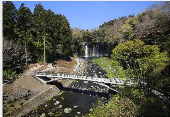
人工構造物撤去・新橋梁（滝見橋）
