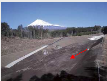
砂沢沈砂地工
