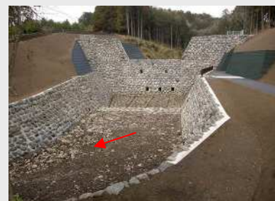
千束第3砂防堰堤
