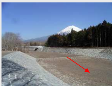
猪の窟溪流保全工
