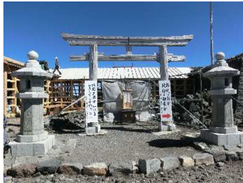
改修中の奥宮
