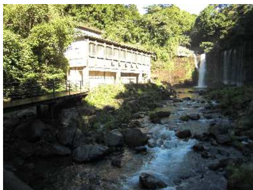
滝壺にあった人工構造物
