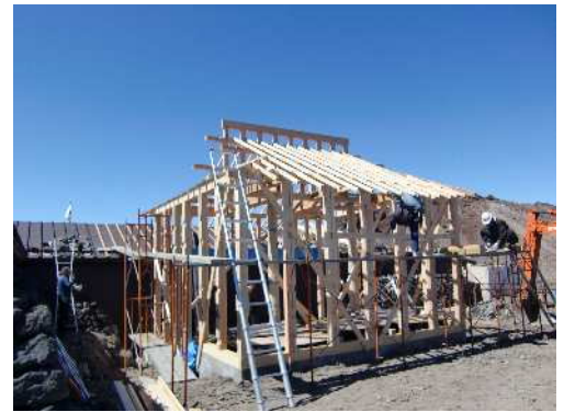
建替え中の奥宮本殿
