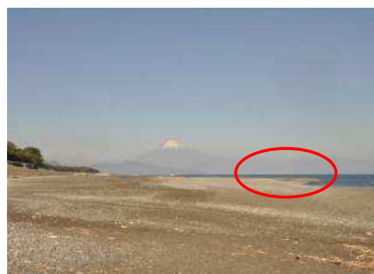
< L型突堤施工後 20年 >
