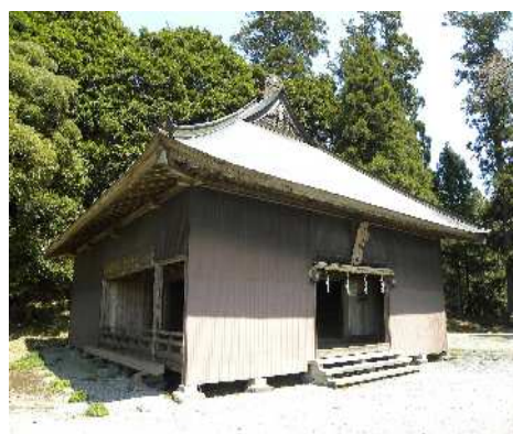
村山浅間神社・大日堂修理前
