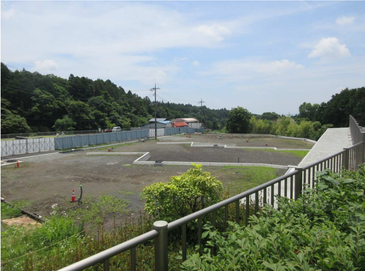
整備後写真(駐車場から)
