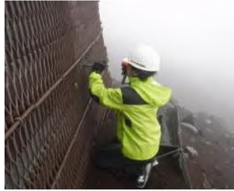
緑化工（挿し木）試験施工実施状況
