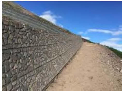
化粧パネル工施工箇所
