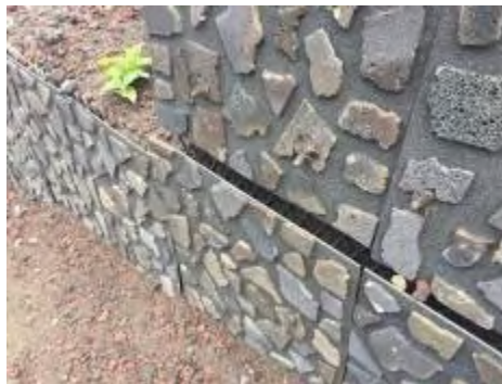
化粧パネル工施工箇所
