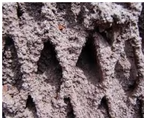
吹付工施工表面
