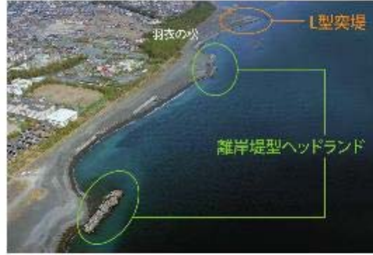
【離岸堤型ヘッドランド】【L型突堤(突堤型ヘッドランド)】
