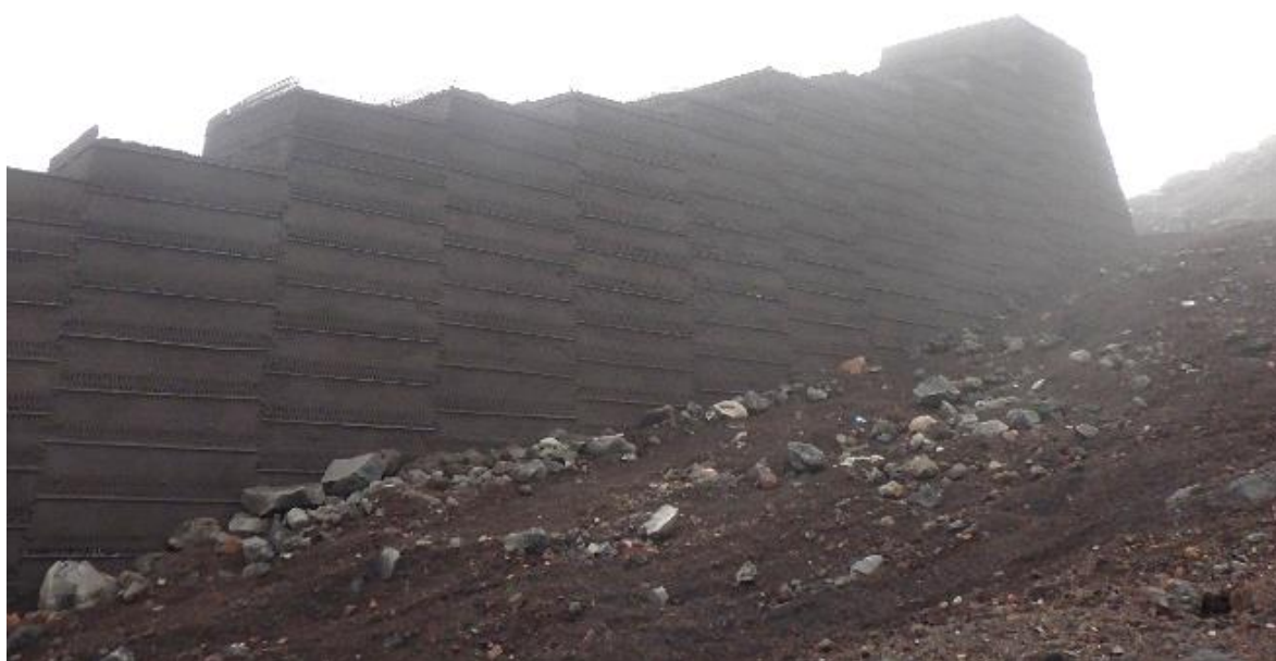
写真 導流堤施工例(着色後)
