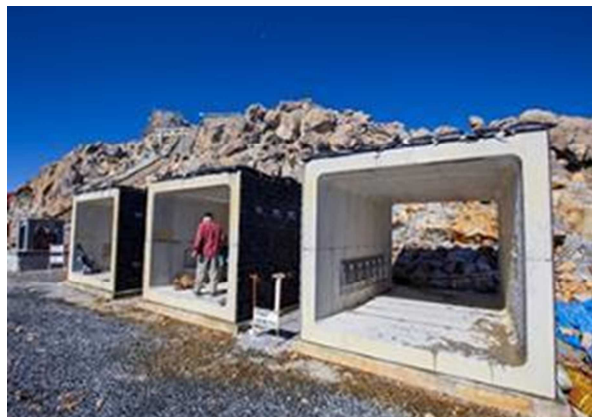
写真9 ボックスカルバート
