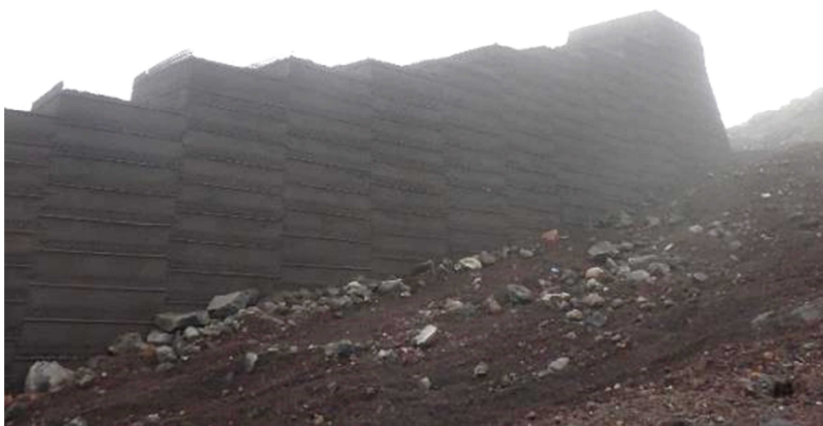
写真14 導流堤施工例(着色後)
