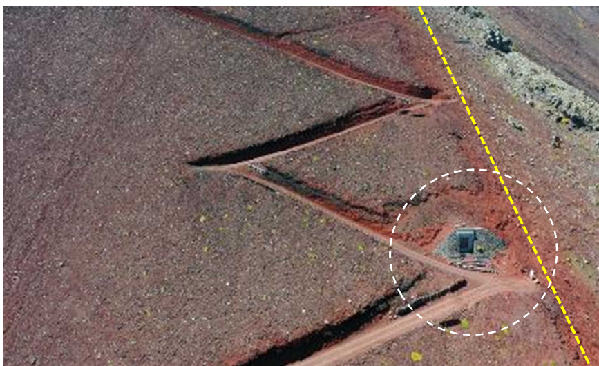
写真8 尾根部に設置されている緊急避難小屋
