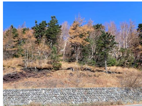
▼ 視点2 : 下部道路より正面を見る
