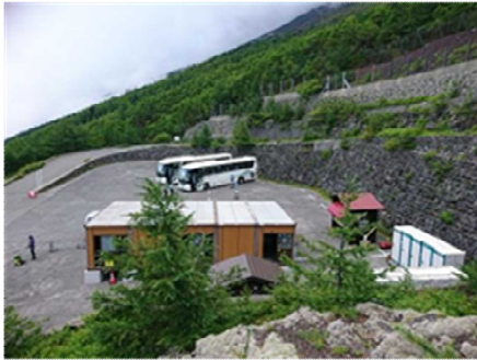
▼バス駐車場、仮設トイレ、仮設休憩所
