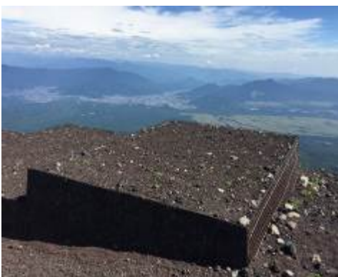
天端スコリア敷均し工施工箇所
