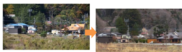
建築物の修景（富士河口湖町）
