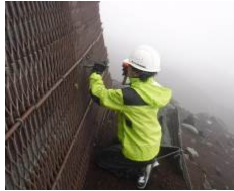
緑化工（挿し木）試験施工実施状況
