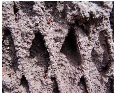
吹付工施工表面
