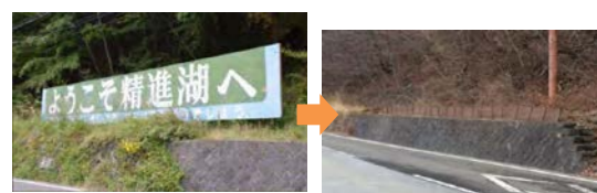
屋外広告物の撤去（富士河口湖町）
