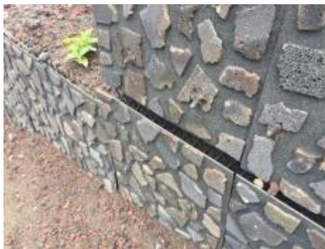
化粧パネル工施工箇所
