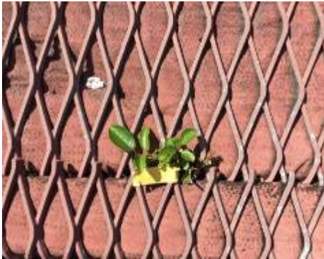
緑化工（挿し木）実施箇所（定着したもの）
