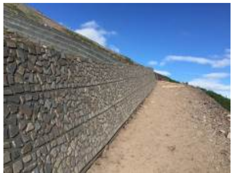
化粧パネル工施工箇所
