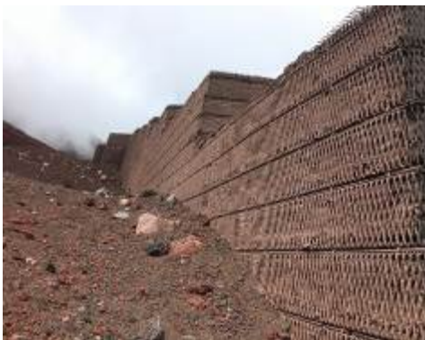
吹付工施工箇所
