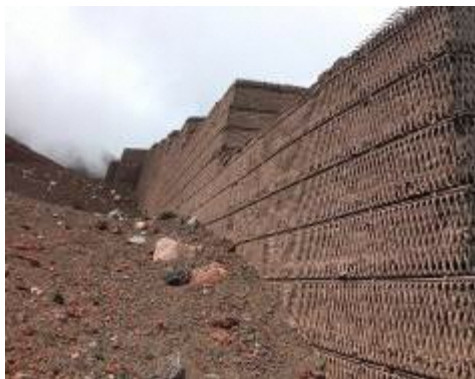
吹付工施工箇所
