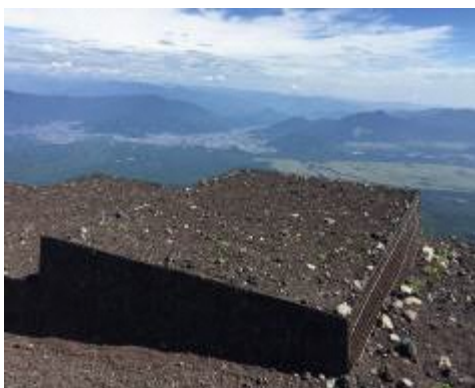
天端スコリア敷均し工施工箇所
