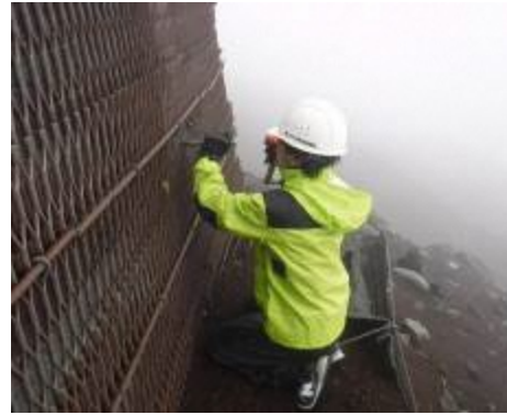
緑化工（挿し木）試験施工実施状況
