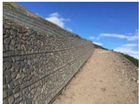
化粧パネル工施工箇所
