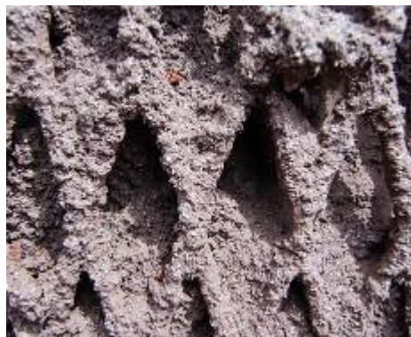
吹付工施工表面
