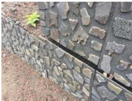
化粧パネル工施工箇所
