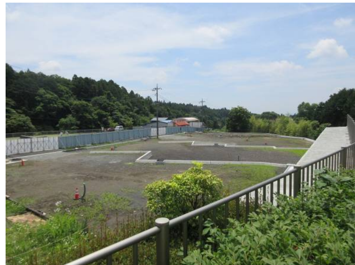
整備後写真(駐車場から)
