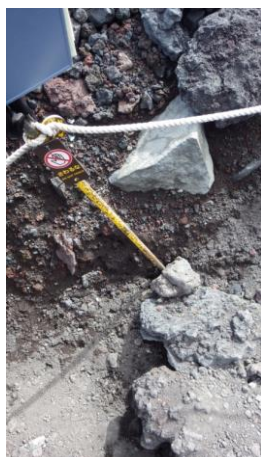
図表 6-9 鉄杭・鉄棒の脱落状況（～頂上）
