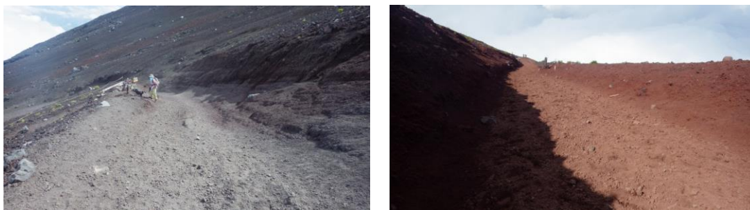
図表6-12 登山道の洗掘発生状況
