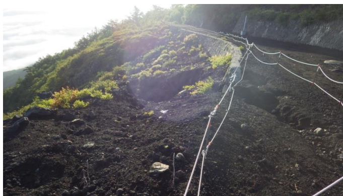
図表 6-2-2 斜面及び登山道の洗掘状況
