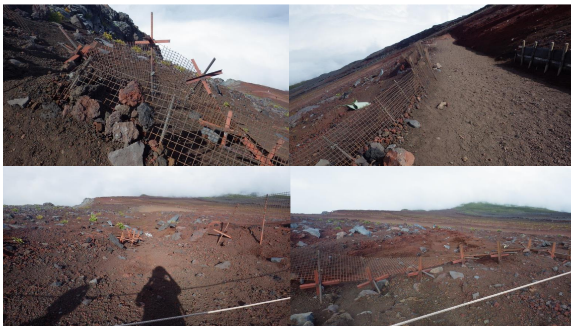
図表6-15 ①に関する雪による土留め工の破損状況
