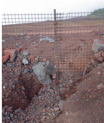
図表 6-18 ②に関する土留め工の破損状況
