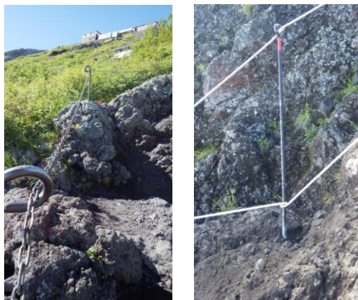
図表 6-8 鉄杭・鉄棒の補修・脱落状況（～8 合目）
