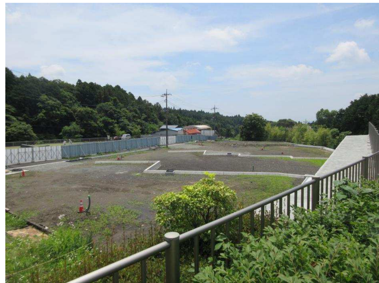
整備後写真(駐車場から)
