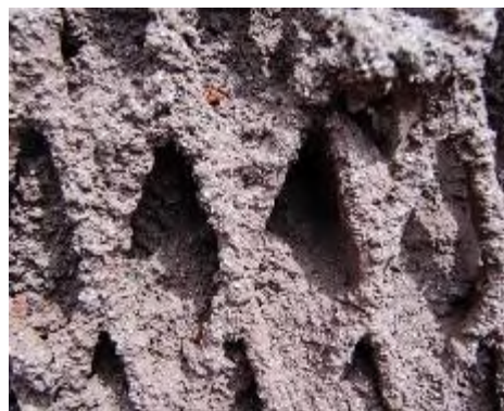
吹付工施工表面
