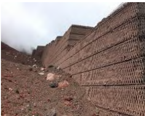
吹付工施工箇所
