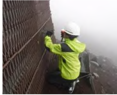
緑化工（挿し木）試験施工実施状況
