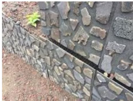
化粧パネル工施工箇所
