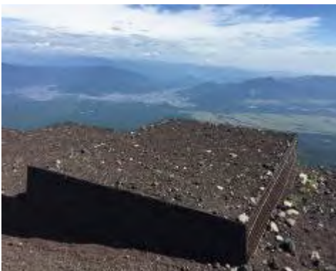
天端スコリア敷均し工施工箇所
