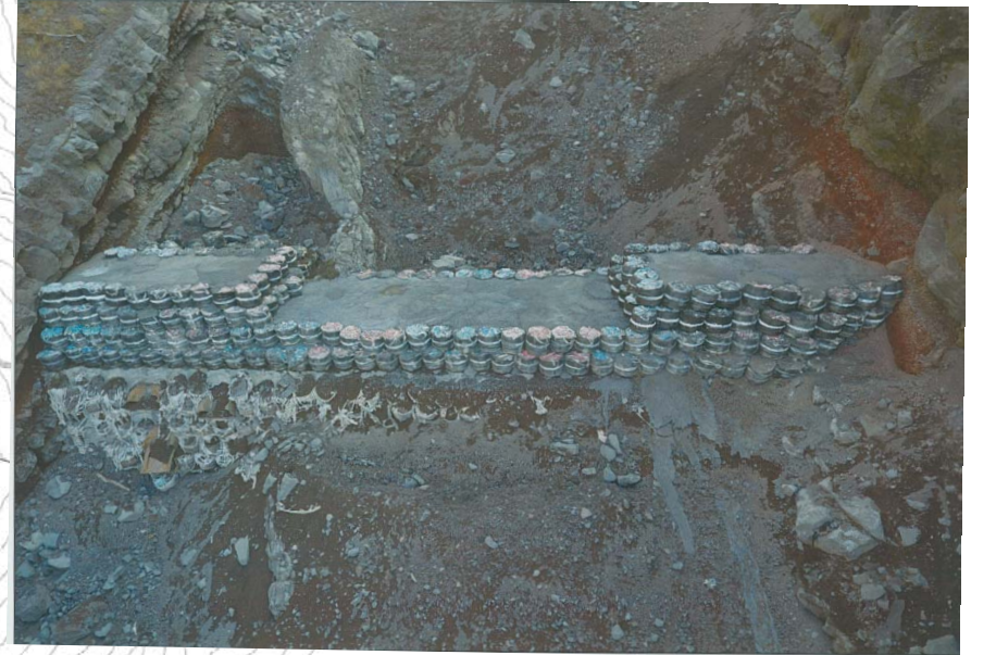
2号横工 下流側より望む
