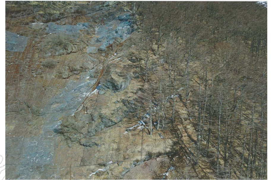
斜面对策工 右岸斜面
