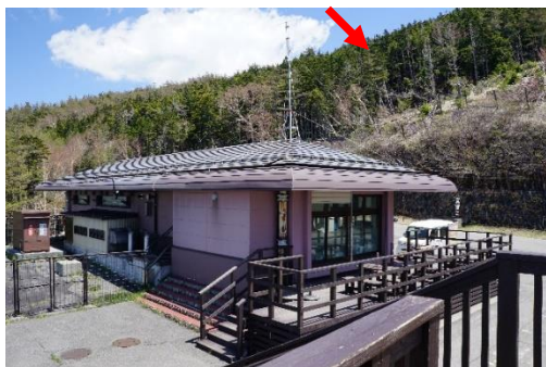
写真 定点観測地点（大沢駐車場）
