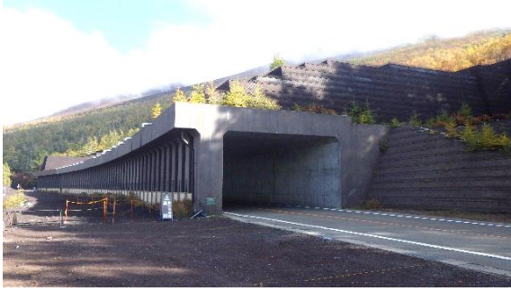
写真 本事業箇所と同規模の施工例
