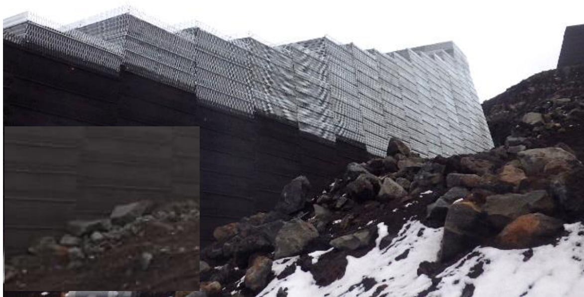
写真 導流堤施工例(着色前)
