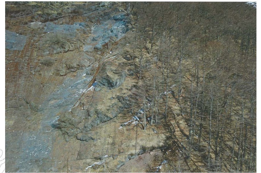
斜面对策工 右岸斜面
