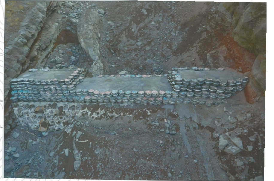
2号横工 下流側より望む
