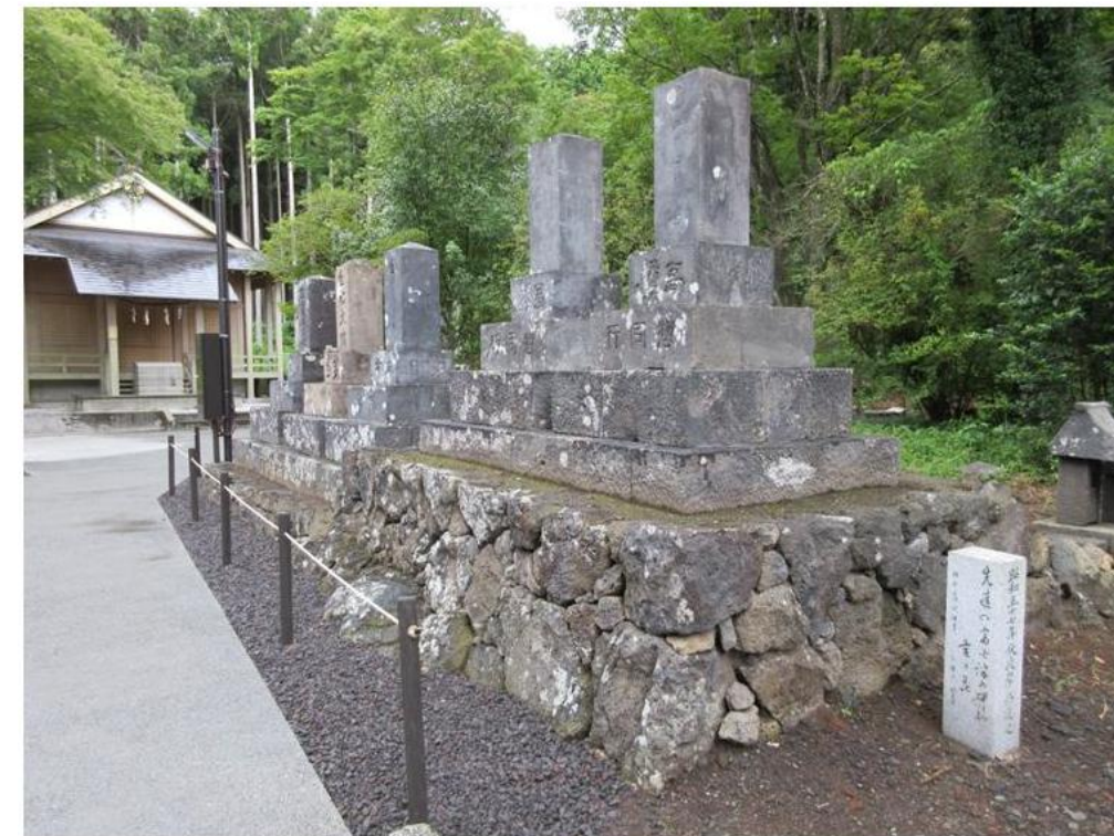
碑塔群(修復後)
